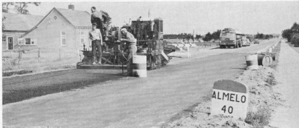
Op de objecten zelf zijn geen legers workers meer; een door enkele mannen bediende machine „maakt” de asfaltweg.
