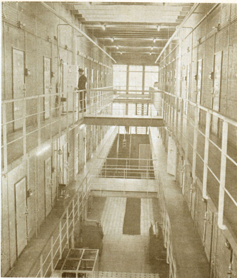
Drie verdiepingen van staal en beton vormen de cellenvleugel in de Leeuwarder gevangenis, waar een man stierf door cyaankali.
